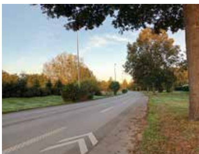
Les chaucidous sécurisent les déplacements à vélos en partageant la voie avec les véhicules.
